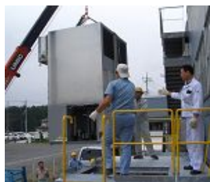
脱臭装置製作据付
